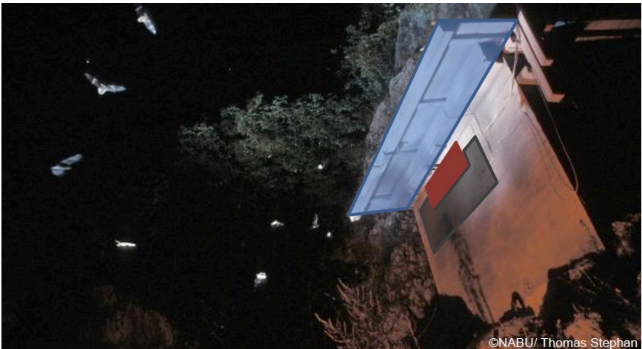
Abbildung 8: Beispiel einer Ein- und Ausflugöffnung am Segeberger Kalkberg Legende: Rot=Einflugöffnung, Grau=Metallverblendung, Blau=Dachvorsprung
