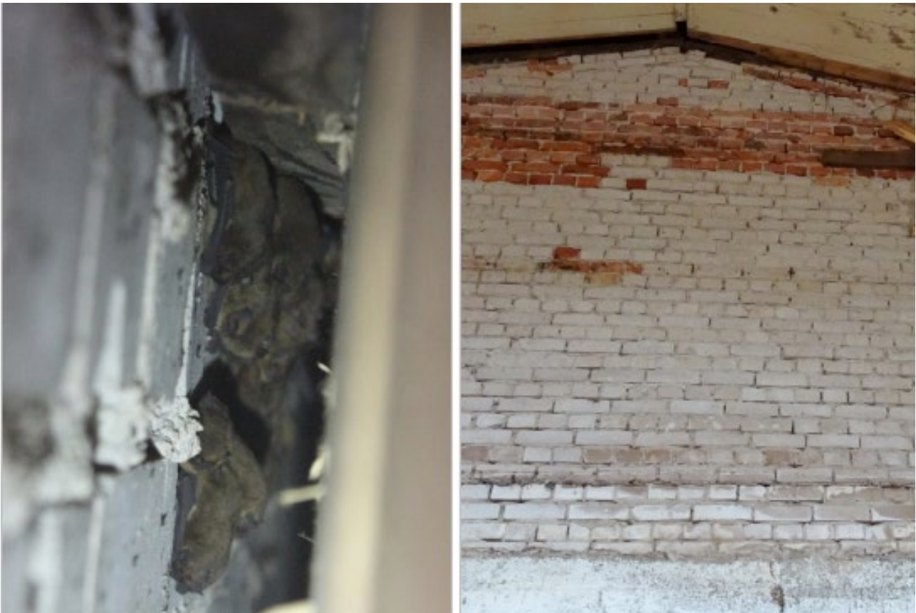
Abbildung 5: Grobes Mauerwerk an Winterquartier
