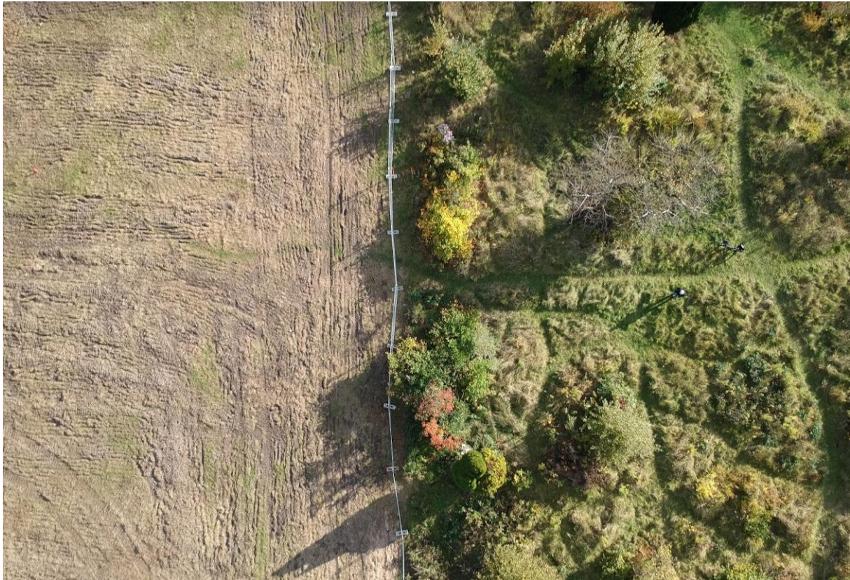
Abbildung 9: Das Baufeld (links) ist durch einen Zaun von den „Flächen für Maßnahmen zur dauerhaften Sicherung der ökologischen Funktion“ klar getrennt, vor dem Eingriff, Lage: westliches Ende des Baufeldes, 17.10.20
